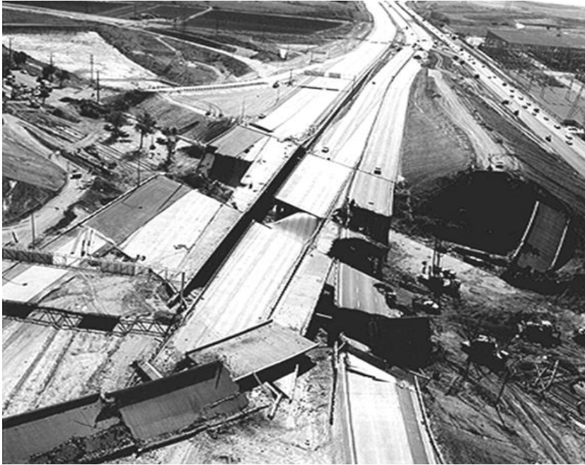
Het ingestorte dubbeldeks segment van de Nimitz highway bij Oakland na de Loma Prieta aardbeving.
